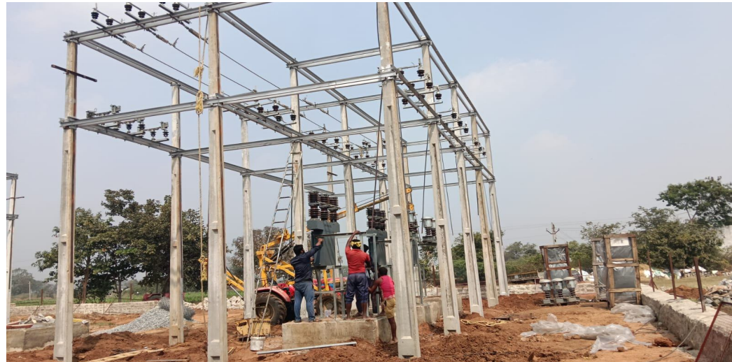
చేకూరానున్నాయి. గ్రామాభివృద్ధికి కీలకమైన ఈ సబ్స్టేషన్ నిర్మాణం పూర్తవుతుందంటే స్థానిక ప్రజలు హర్షం వ్యక్తం చేస్తున్నారు. త్వరలోనే పనులు పూర్తిచేసి సబ్స్టేషన్ ను ప్రారంభించాలని ప్రజలు కోరుతున్నారు
